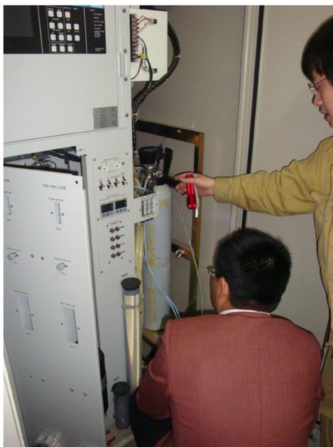
図4 中国某火力発電所脱硝設備出口のリークNH<sub>3</sub>監視モニタ
