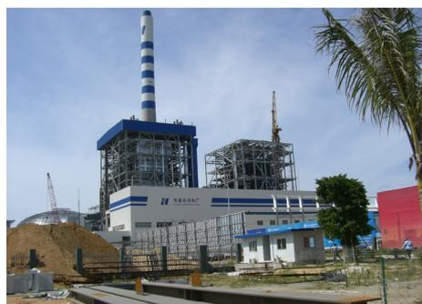
本 PJ については、2009 年稼働後約 3 年が経過しているが、CFD（コンピュータによる流動解析）では判りにくいガス偏流が見られ装置面での偏流対策などの改善が必要であり、SCR 設計・施工会社にて対応を進めている段階。
